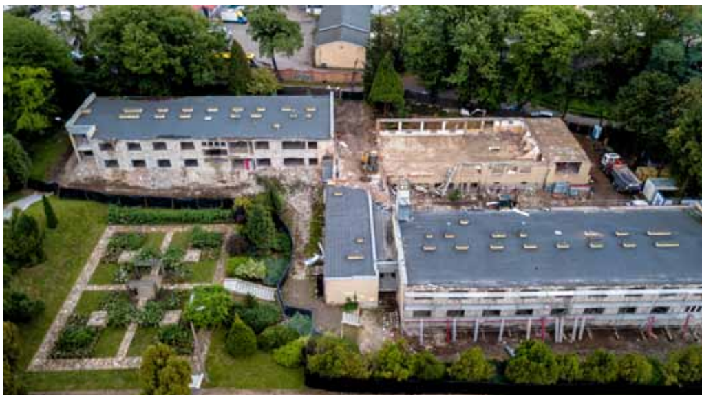
Aktualnie trwają prace remontowe w budynku byłego internatu w Parku Sanguszków, gdzie pod koniec przyszłego roku ma powstać Centrum Rehabilitacji Społecznej i Zawodowej Zakład Aktywności Zawodowej „Słoneczne Wzgórze”.
